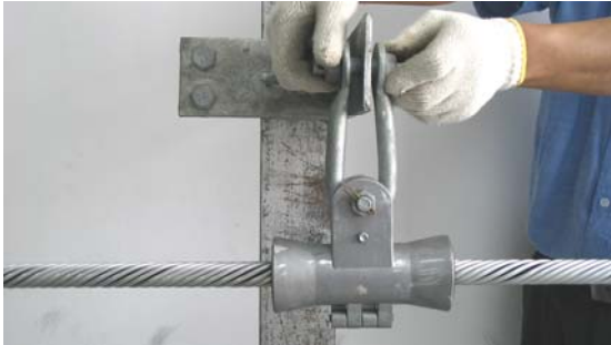
9、将 U 型挂环固定在杆塔上，插上闭口销。
