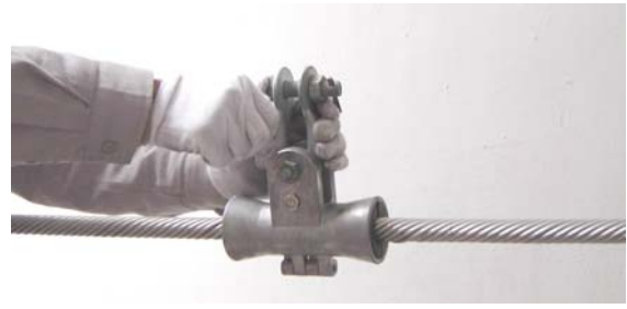
8、放入 U 型挂环，装好 M12 螺栓，插上闭口销。
