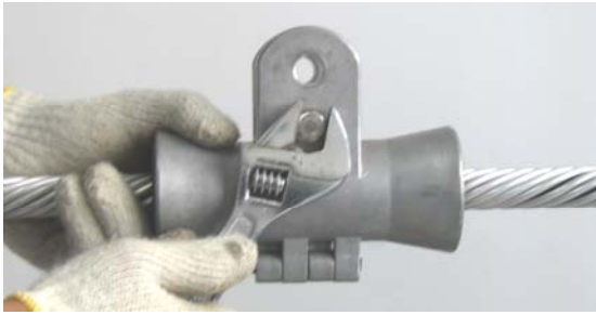
7、调整线夹的挂耳使其向上，拧紧 M8 螺栓，压紧光缆，注意不要压伤光缆。
