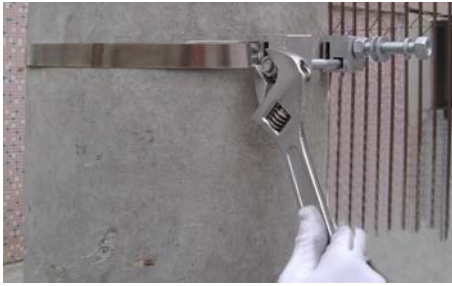
7、调整好光缆引下的位置，拧紧螺栓。
