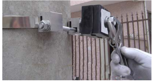
8、装上并沟线夹或橡胶夹，然后把光缆装入并沟线夹或橡胶夹拧紧螺母即可。安装完毕！
