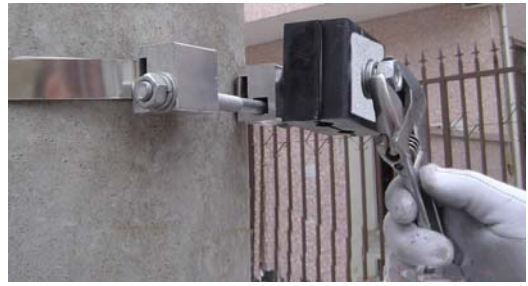
8、装上并沟线夹或橡胶夹，然后把光缆装入并沟线夹或橡胶夹拧紧螺母即可。安装完毕！
