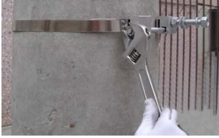
7、调整好光缆引下的位置，拧紧螺栓。
